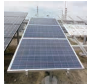
FREA実証フィールドに設置された太陽電池モジュール
