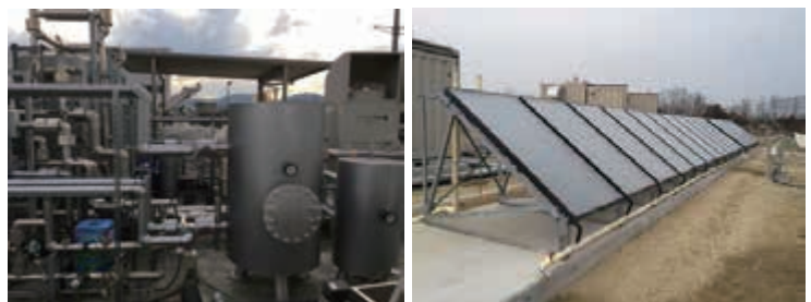
温度成層式予熱槽と、それに接続する太陽熱集熱パネル
