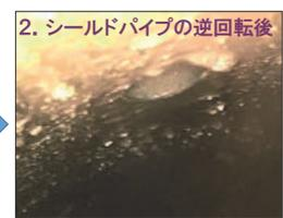
有孔部から地下水の流入量が増加し、地下水の流動を確認
