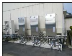
地中熱ヒートポンプ 3台
