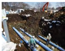
ジオプロロード(熱交換用パイプ)
