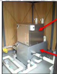
既存の井戸と接続した熱交換ユニットとヒートポンプ
