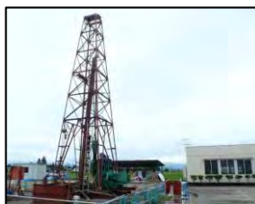
井戸掘削 Φ250×100m
