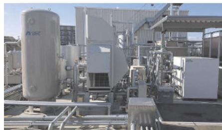
統合化した蓄熱槽・熱発電システム
