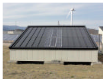
模擬屋根を用いた屋外曝露試験を開始
