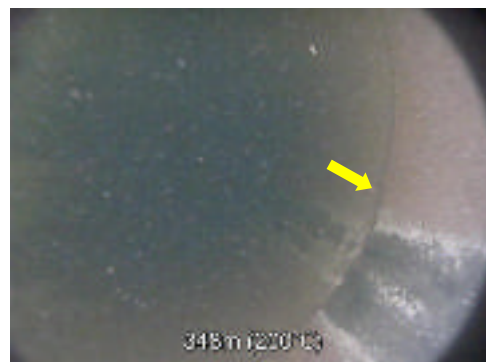
地熱井(約200℃の環境で撮影した孔壁のイメージ。坑井を崩落等より保護するケーシング管の継ぎ手が写っている。)
